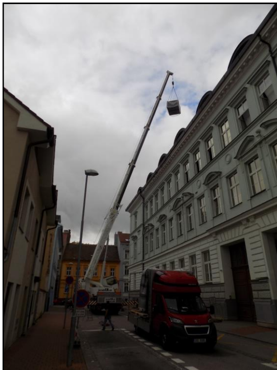
10-Osazení chladiče vody na protiotřesové pásky
